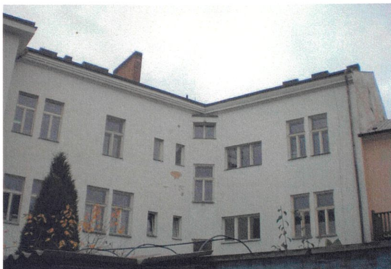
Pohled na SZ a SV fasádu orientovanou směrem do dvora
