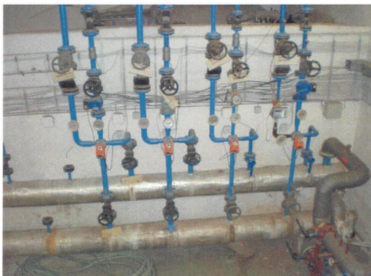
Rozdělovač a sběrač s napojením jednotlivých otopných větví ÚT
