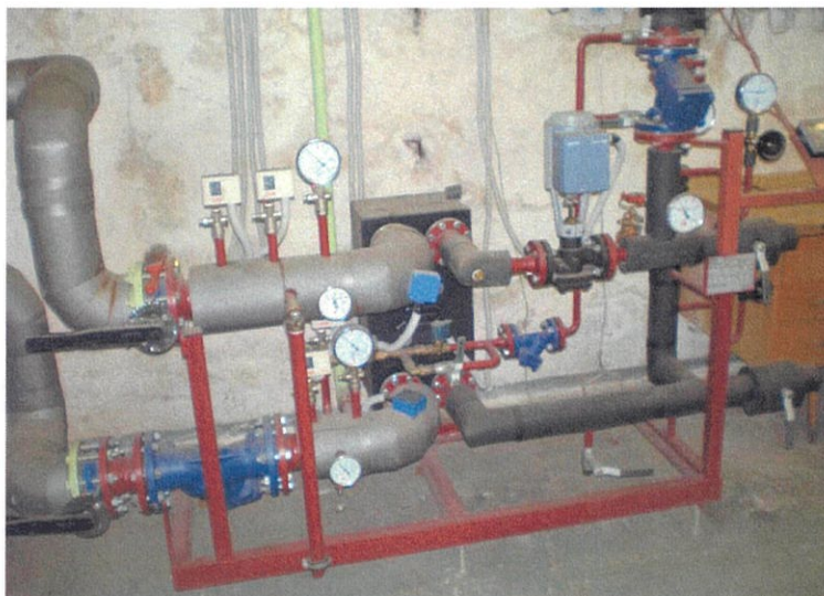
Výměňníková stanice značky Systherm v majetku dodavatele tepla společnosti Centrotherm a.s.
