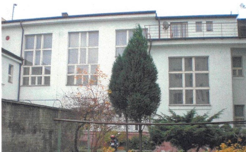
Pohled na JZ fasádu orientovanou směrem do dvora
