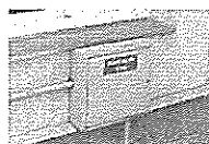
OBRÁZEK 13 – HLAVNÍ UZÁVĚR PLYNU
